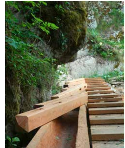
**Neben dem bereits gelegten Känel ist der Gehsteig zu sehen; die Lärchenbalken, die hier noch auf der Brücke liegen, werden aufgestellt und bilden dann das Gelände zur Sicherheit der Hüter Wasserleiten-Hirte) oder der Wanderer.**
