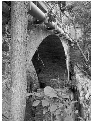
Die alte Steinbrücke aus dem Mittelalter am Fusse des Deischberges, 1883 verbreitert. Rechts an der Brücke wurde die Abwasserröhre zur ARA Brig-Glis angehängt.
