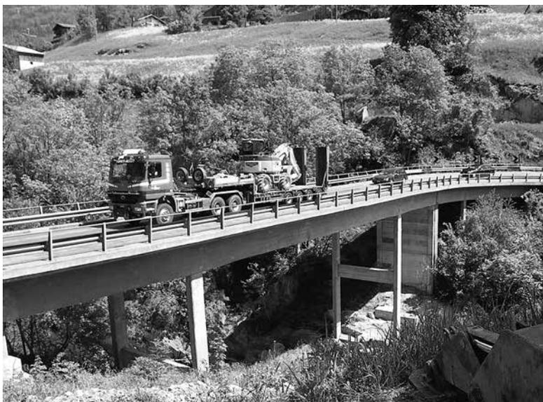
*Die alte Baderbrücke über den Rotten (1940-1942). Die Brücke ist zu schwach und baufällig.*
